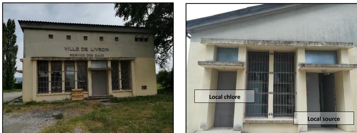
Figure 7 : Photographies des locaux implantés sur la parcelle du puits de Couthiol
