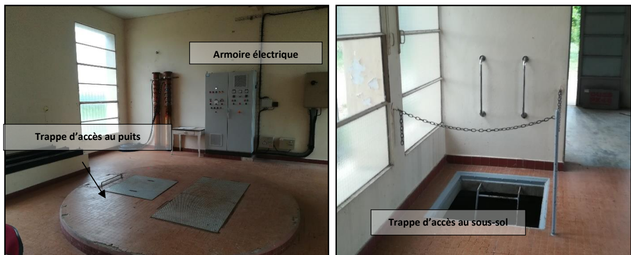
Figure 6 : Photographies des différents accès au captage
